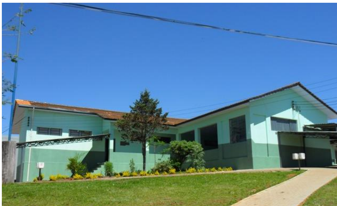
Figura 7. Foto do Colégio Estadual de Renascença Padre José Júnior Vicente Fonte: Instituição de Ensino, maio de 2015.
